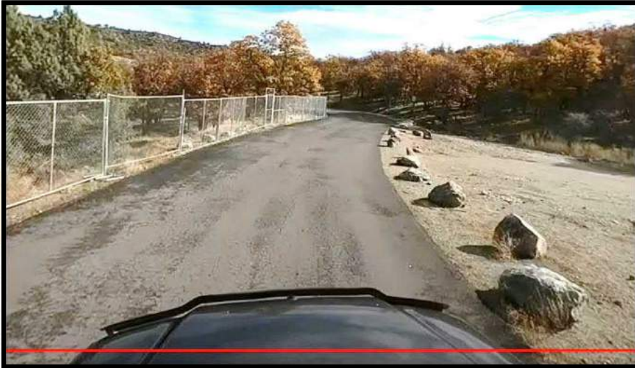
Rt 0042 - Ishpuk Rd
